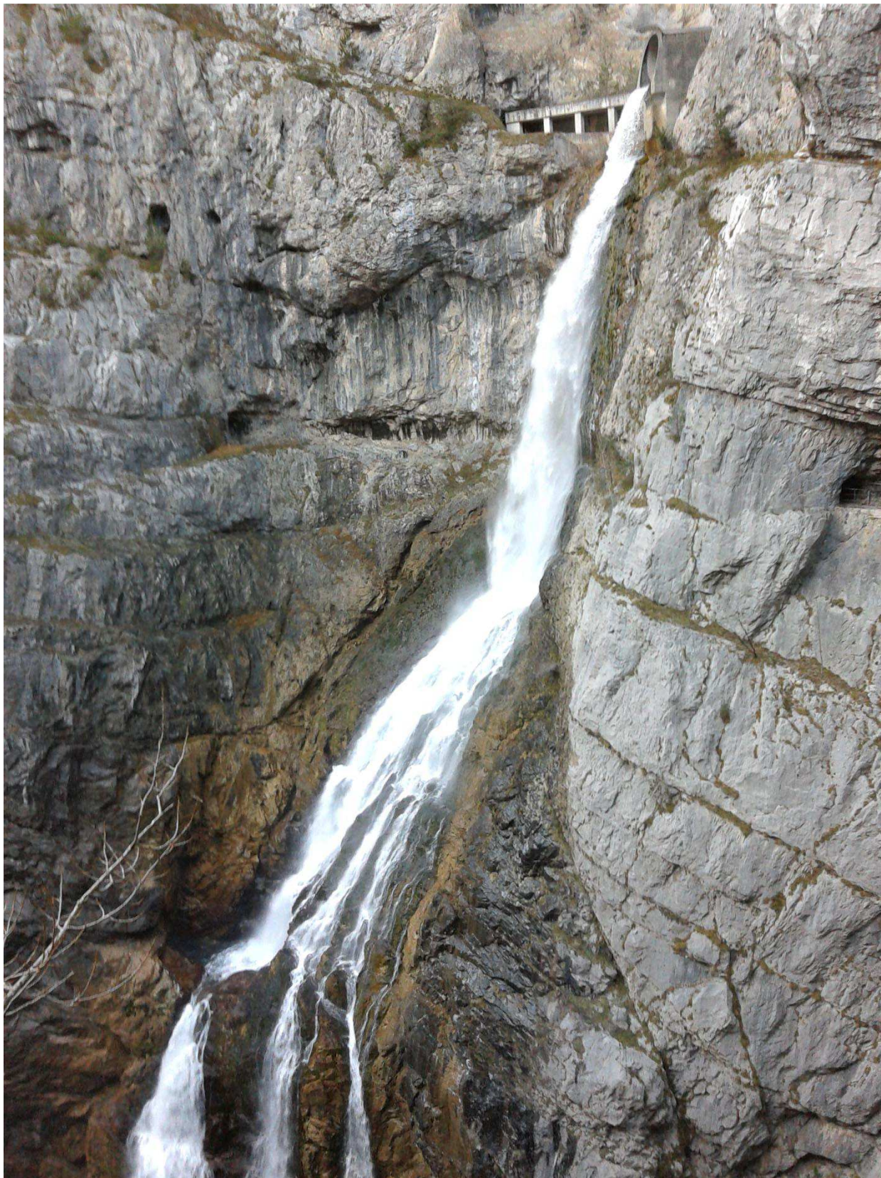
Foto 2: Primo piano dello scarico della galleria di sorpasso che scarica l'acqua dal "lago residuo C" - portata naturale del torrente Vajont. Si notano i potenti spessori di roccia del calcare del Vajont.
