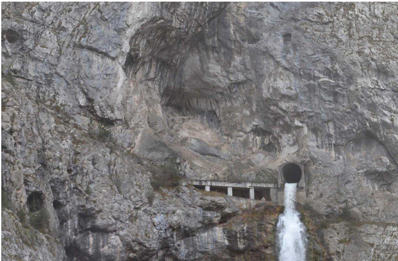
Foto 7: ZOOM 2: ulteriore particolare della parete di roccia circostante la sezione di scarico della galleria di sorpasso. Si nota la nicchia di distacco esistente, entro la quale non si riscontrano ulteriori blocchi o cunei di roccia mobilizzabili.
