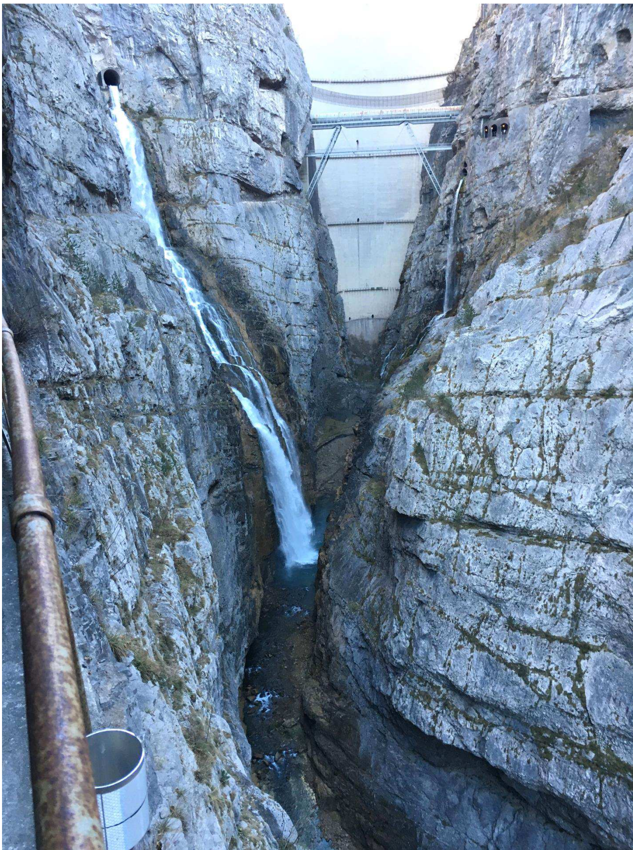
Foto 3: La valle del Vajont nel tratto di interesse fotografata dalla pista di servizio esistente in destra idrografica. La foto testimonia la presenza degli strati massicci del calcare del Vajont fino alla base del torrente, ove si ritrovano i materiali alluvionali.
